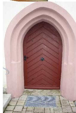
Schreiner, Fensterbauer und Steinmetz waren zwischenzeitlich auch sehr fleißig. So wurden neue Türen angefertigt und eingebaut, die Fenster ausgebaut, in der Glaserwerkstatt saniert und nach der Sanierung der Fenstereinfassungen durch den Steinmetz, wieder eingebaut.
